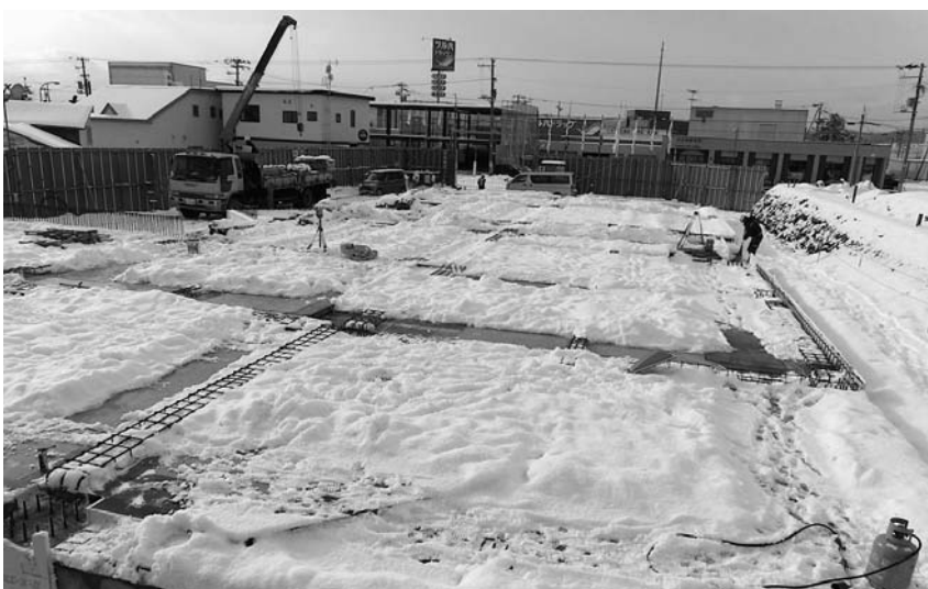
着工された観光交流センター建設工事 いままら8月の完成が待たれます
