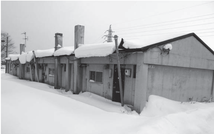
改めて工事契約が結ばれて解体される中野団地
