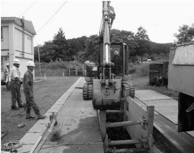
佐女川地区で行われた下水道工事 接続率の向上が求められています
