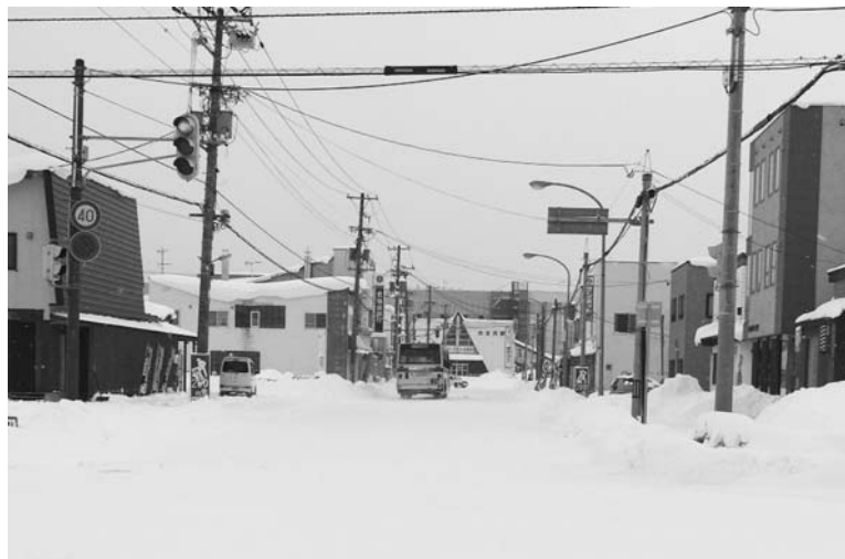
新幹線開業に合わせて整備が進む駅前通。景観統一事業とあわせ、電線地中化工事が進められます
