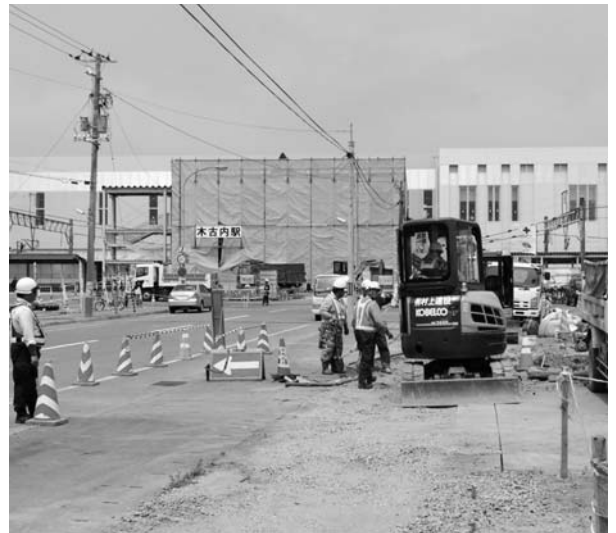
北海道新幹線の開業に向け工事が進む JR 木古内駅前
