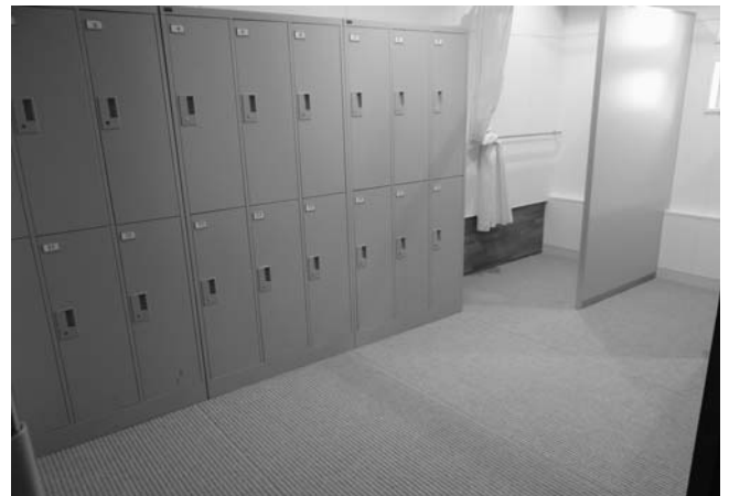
更衣室内の水処理対策として給水マットを設置しました
