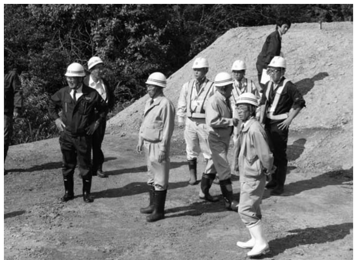
ふるさとの森スキー場リフト改修工事 休憩小屋の設置要望が出されました
