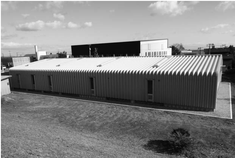
施工方法の見直しが求められたふるさとの森プールの外構工事
