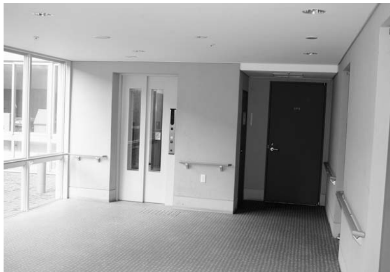
防犯カメラが設置される「いさりび団地」エレベーター前など3か所に設置予定
