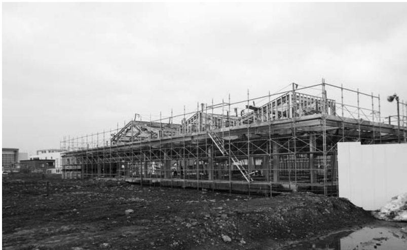
着々と建設工事が進み姿を現した観光交流センター (平成27年8月完成予定)
