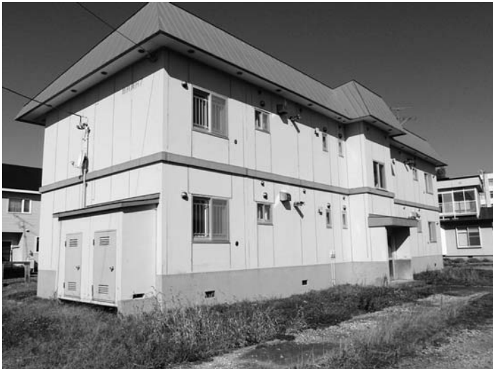
3月下旬に購入し、職員住宅として改修を予定している旧道職員住宅（新栄町地区）
