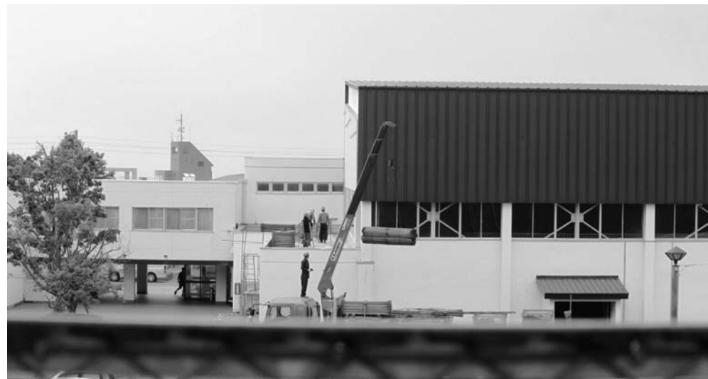
7月から12月頃まで 耐震改修工事を実施する スポーツセンター
