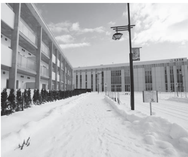
道営住宅「であえ〜る駅前団地」(写真左) 駅北口側に位置しアクセスもよい
