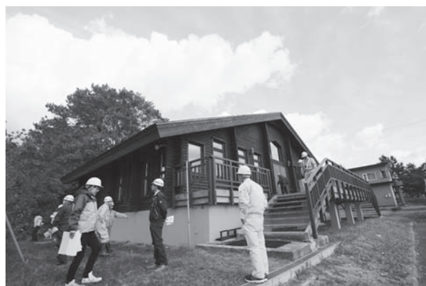
外壁を塗装したスキー場ロッジ
