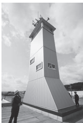
耐震補強された消防署庁舎望楼
