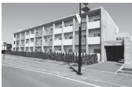
森林組合事務所跡地付近に道営住宅2号棟が建設される予定（写真は1号棟）
