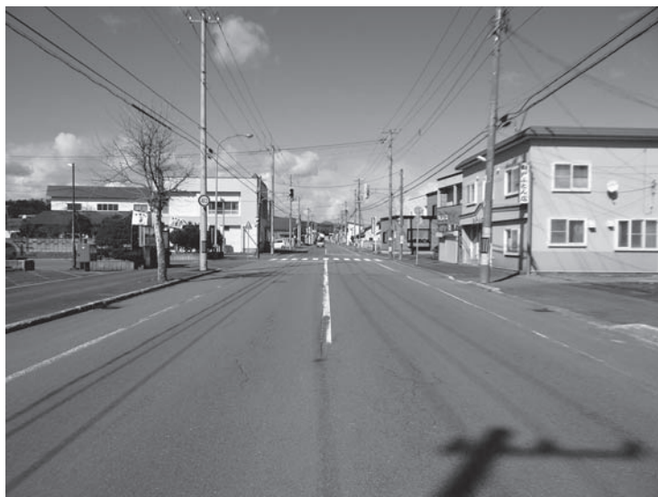
改良工事が予定されている道道5号線（中央通り）
