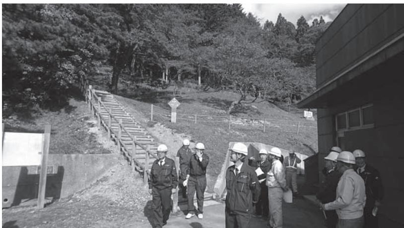
「薬師山・萩山遊歩道整備工事」現地調査の様子
