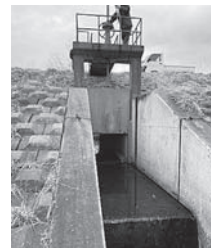
木古内川樋門
