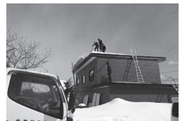
屋根の雪下ろし
