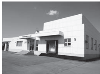
木古内町学校給食センター
